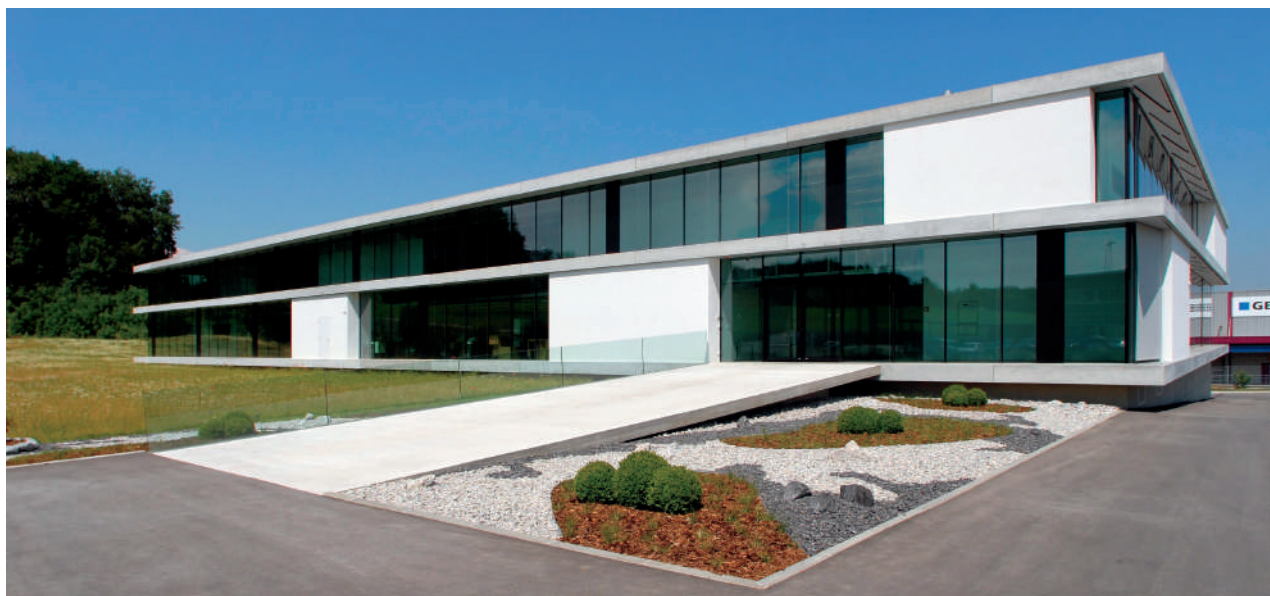
Les locaux de Gainerie Moderne à Givisiez
