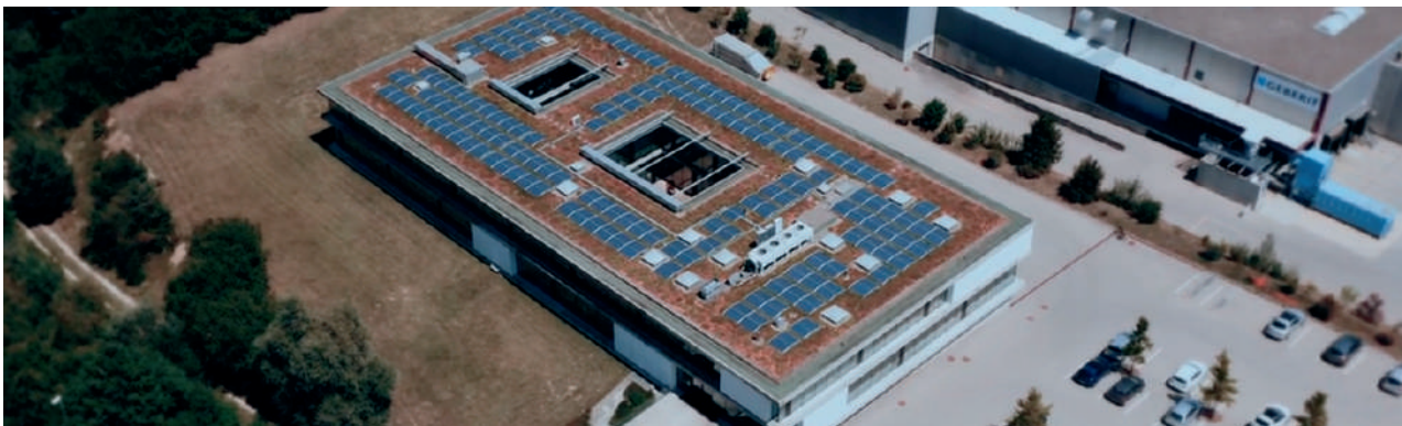
Toiture des locaux de Gainerie Moderne à Givisiez
